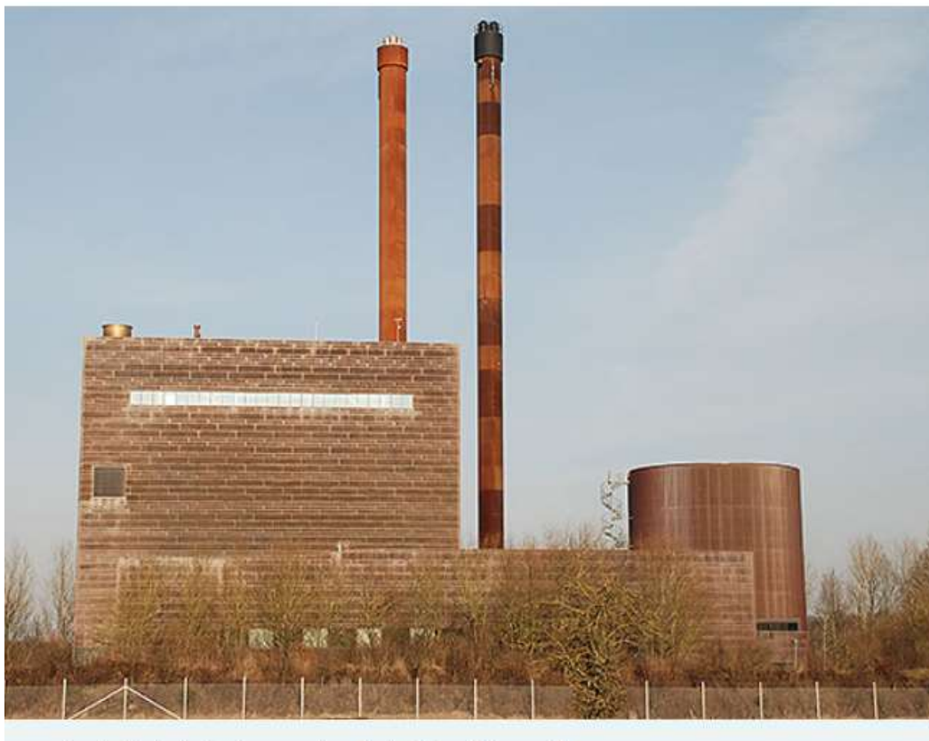
Figur 6 - Forgasningsanlæg i Skive
