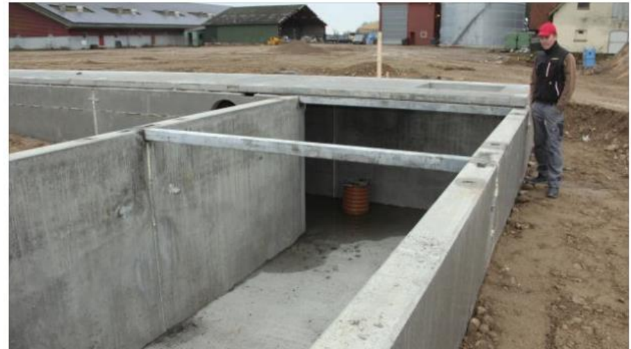
Luftrensere kobles til en luftkanal, der løber midt i stalden.
